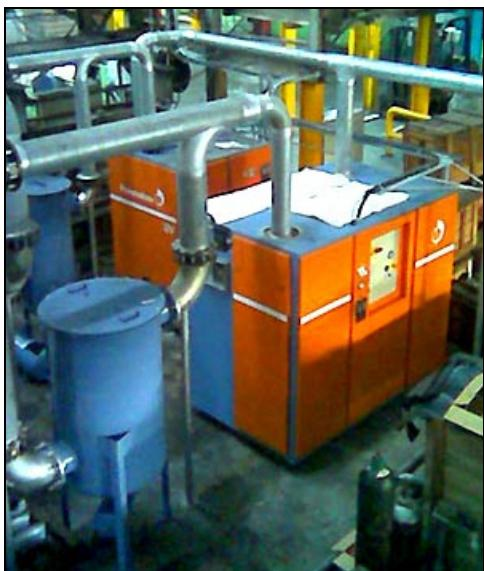
Die Zusammenarbeit mit Malaya Glass begann im Jahr 2004, als ein neues Vakuumsystem für die Bottero IS Maschine installiert wurde. Seitdem sind zwei Pumpen Modell UV8 und zwei Modelle UV16 im Betrieb mit allen speziellen Zubehörteilen, zu voller Kundenzufriedenheit. Denn das Ziel der Hochgeschwindigkeitsfertigung von Glasbehältern mit der niedrigsten Ausschussrate wurde erreicht.
