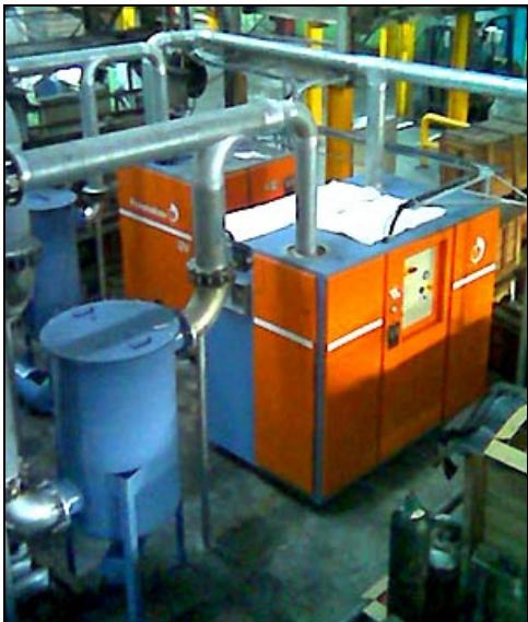
La cooperación con Malaya Glass empezó en 2004 cuando fué instalado un nuevo sistema de vacío por máquinas IS de Bottero. Desde entonces, dos bombas modelo UV8 y dos modelos UV16 con sus propios accesorios trabajan continuamente con total éxito del cliente. El objetivo de producción superior de envases en vidrio con una reducción notable de desperdicio, fue alcanzado totalmente.
